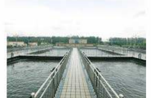
水利工程 河北省水利工程局 Hydraulic project-Hebei Water Conservancy Engineering Bureau
